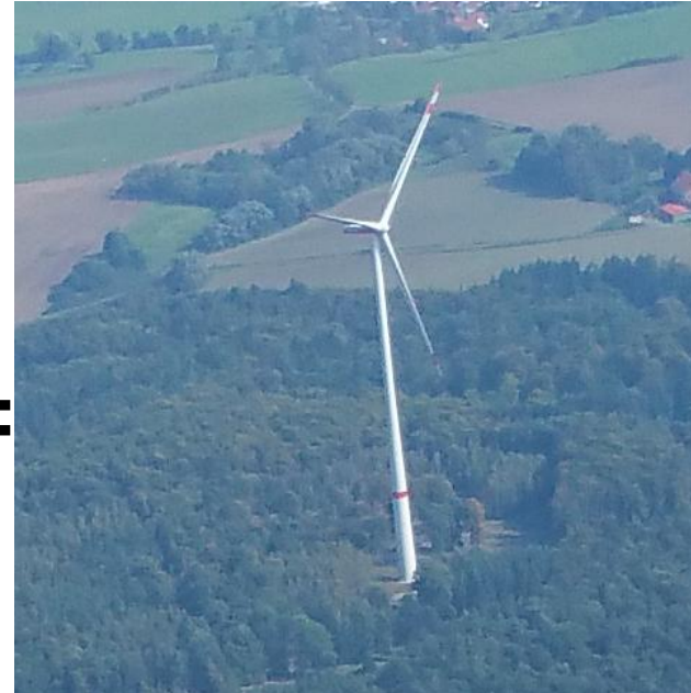
Staufenberg: 1 Anlage mit 247 m
