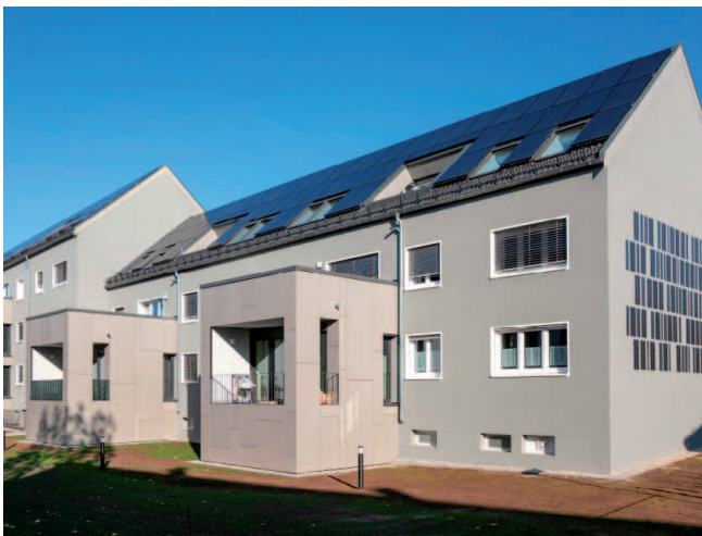
Abbildung 2: Geothermie zur Versorgung von Mehrfamilienhäusern in Frankfurt Riederwald
