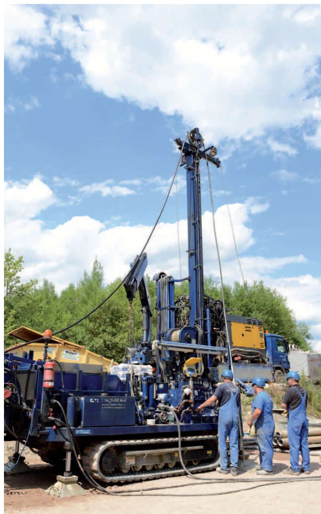
Abb. 34: Geothermie-Bohrgerät im Einsatz
