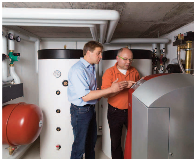
Abbildung 38: Blick in den Technikraum einer Wärmepumpenheizung
