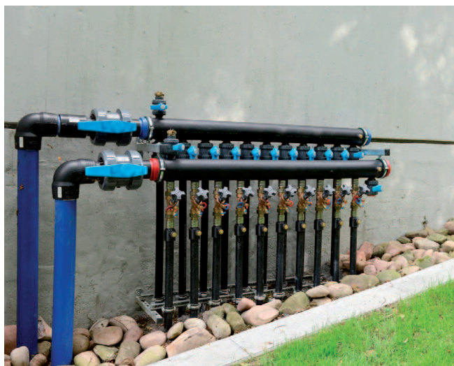
Abbildung 4: Soleverteiler eines Erdsondenfelds
