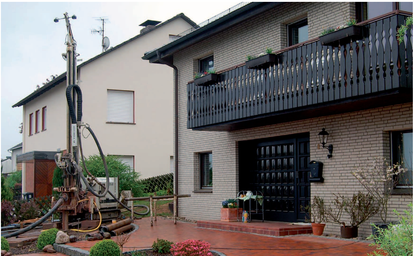
Abbildung 32: Erschließung von Erdwärme im Vorgarten eines Mehrfamilienhauses
