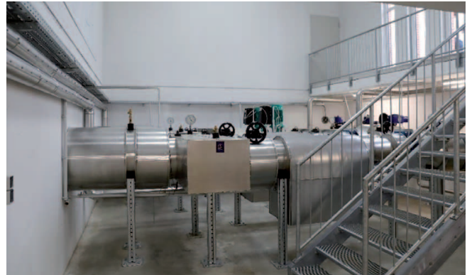
Abbildung 27: Blick in die Energiezentrale
