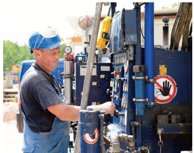
Abbildung 5: Blick auf die Steuerinstrumente eines Geothermie-Bohrgeräts
