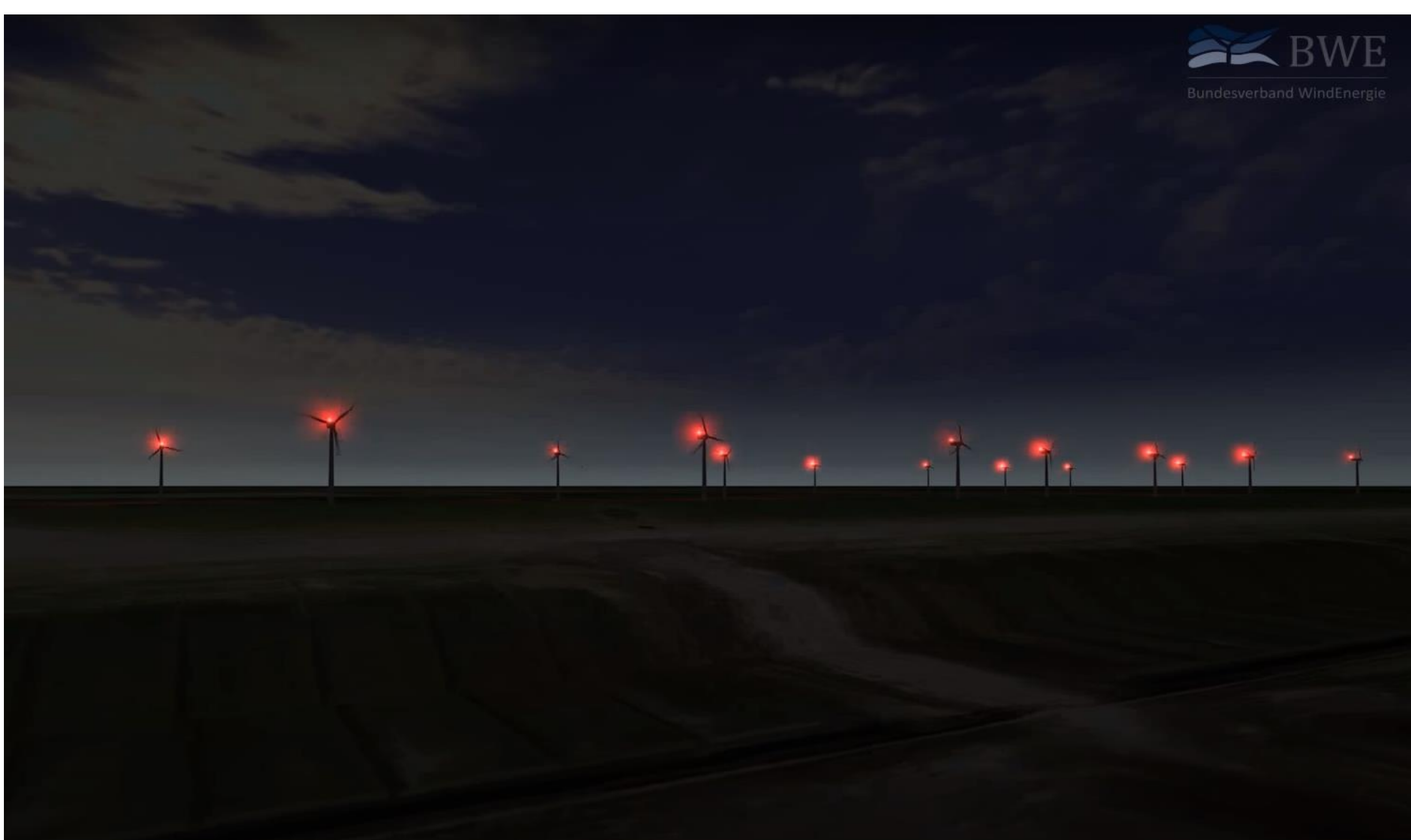
Die Befuerung der Anlagen mit BNK ist sichtbar: Ein Flugobjekt befindet sich innerhalb des 6 km Umkreises um die Anlagen
