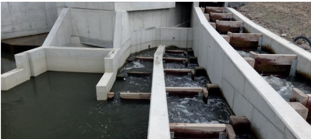
Abbildung 10: Beispiel einer Fischaufstiegstreppe, Vertical-Slot mit Holz (Quelle: © Hydro-Energie Roth GmbH)
