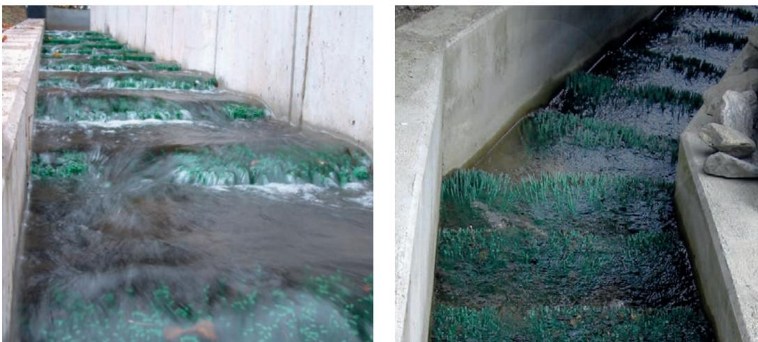
Abbildung 11: Beispiel eines Borstenfischpasses (Quelle: © Hydro-Energie Roth GmbH)
