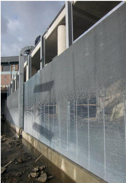
Abbildung 14: Horizontal-Leitrechen nach Gluch im trockengelegten Staubereich einer Wasserkraftanlage (Quelle: Dr. Ronald Steinhoff)
