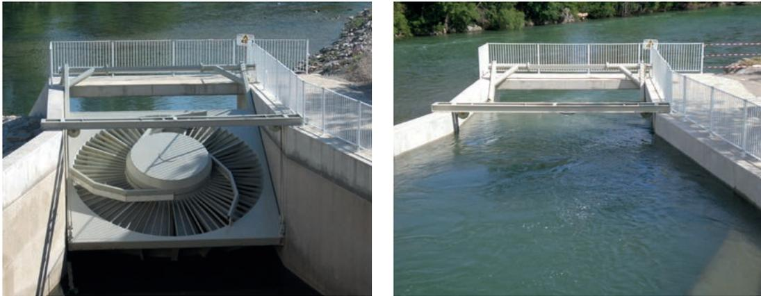
Abbildung 21: Beispiel einer VLH Turbine im angehobenen Zustand (Servicestellung) und im Betrieb (Quelle: MJ2 Technologies S.A.S. [www.vlh-turbine.com](http://www.vlh-turbine.com))
