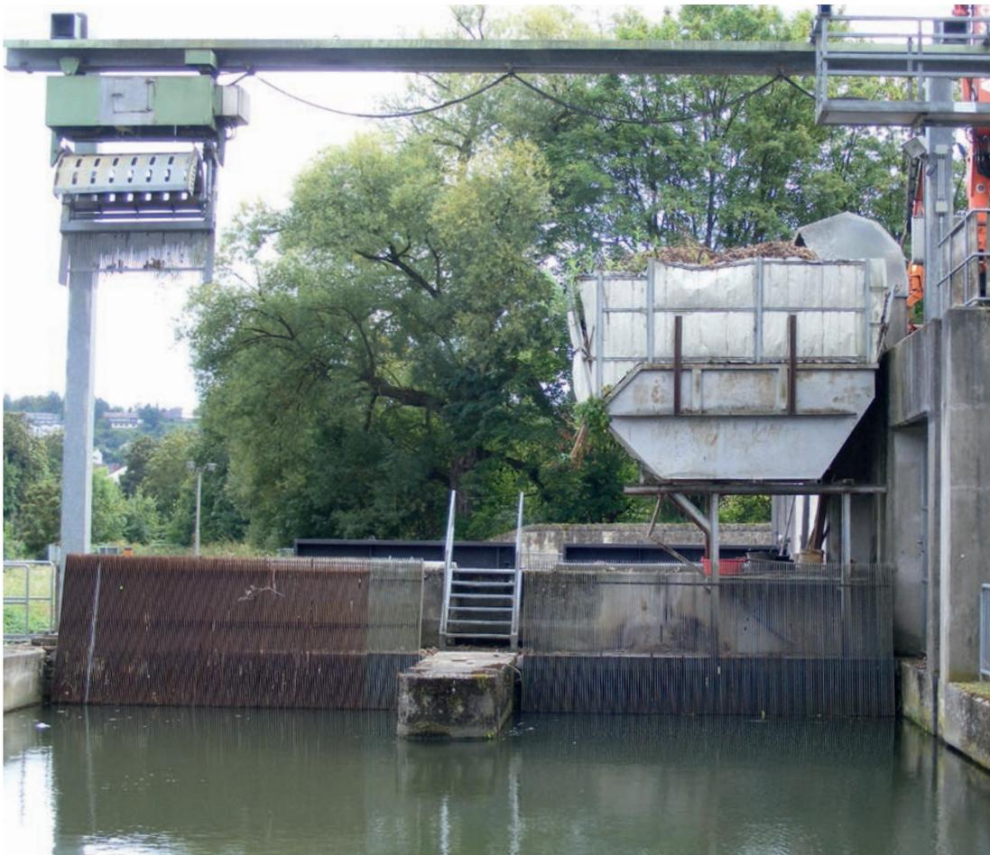
Abbildung 8: Rechen mit Reinigungsanlage (Quelle: Winfried Klein)
