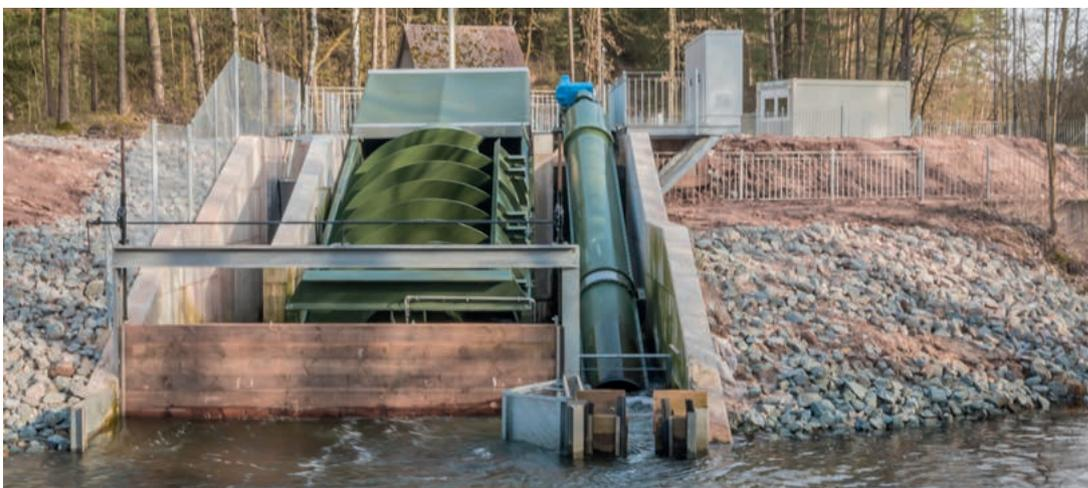
Abbildung 12: Beispiel einer Fischaufstiegsschnecke (Quelle: Rehart GmbH, Ehingen)
