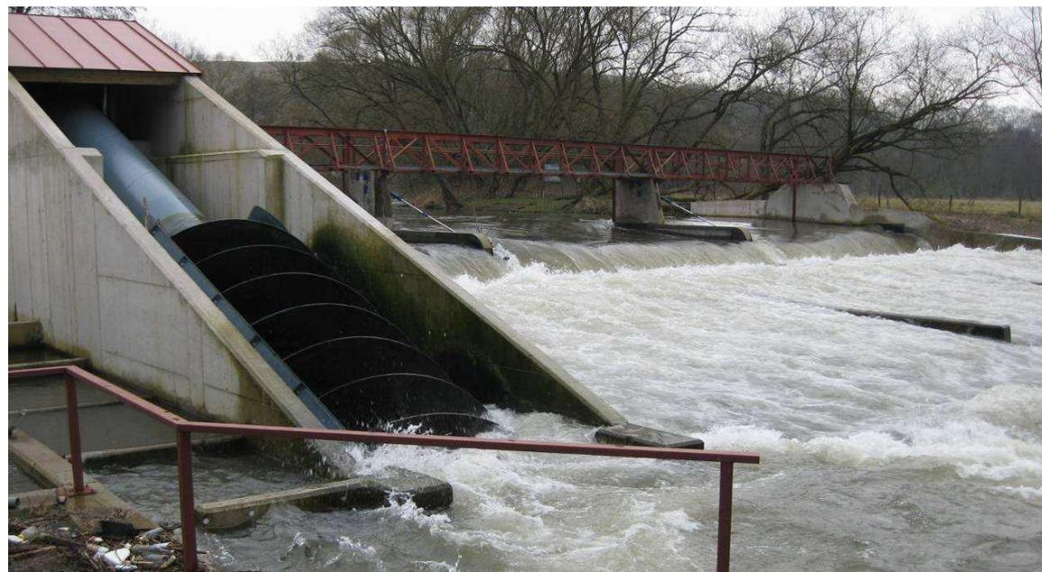
Wasserkraftschnecken werden immer für Fische als ungefährlich bzgl. Abstieg dargestellt. Diese vorliegende Untersuchung belegt das Gegenteil.
