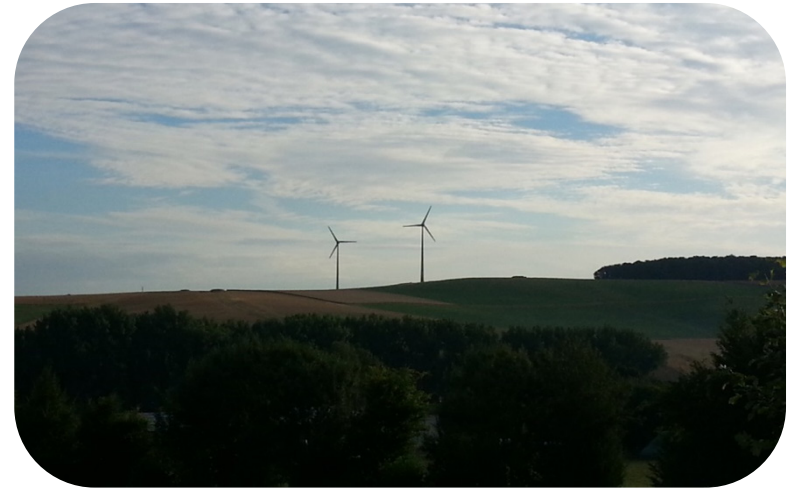
Nabenhöhe / Rotordurchmesser : 98 m, 66 m, Nennleistung: 1,5 MW
