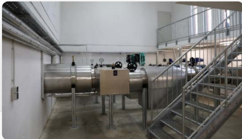
Innenansicht Energiezentrale (Netzpumpen)
