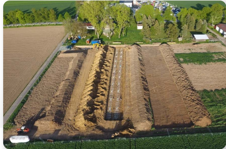
Kollektorfeld von oben
