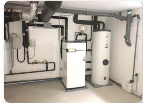
Wärmepumpe im Wohnhaus
