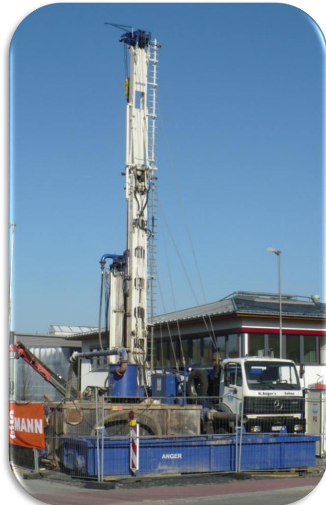
780 m-Bohrung Heubach, Foto: Fritsche
